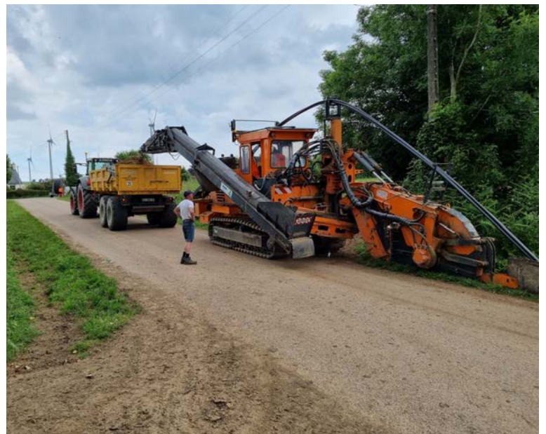
Travaux de déploiement de la fibre juin 2021 Plouyé
