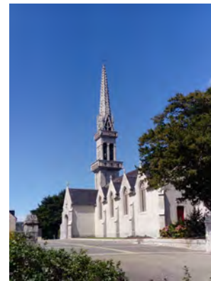
Ravalement de l'église Coût de l'opération : 67 968€ TTC. (2018)
